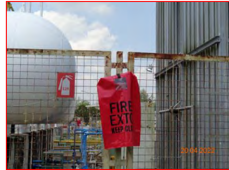
ภาพที่ 2.2-44 การติดตั้งถังดับเพลิงผงดมแห้ง บริเวณลานถังเก็บ LPG
