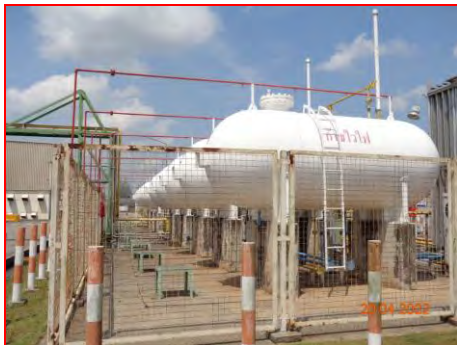
ภาพที่ 2.2-39 รั้วตาข่ายโปร่งกัน และเสาป้องกันการกระแทก บริเวณลานถังเก็บ LPG
