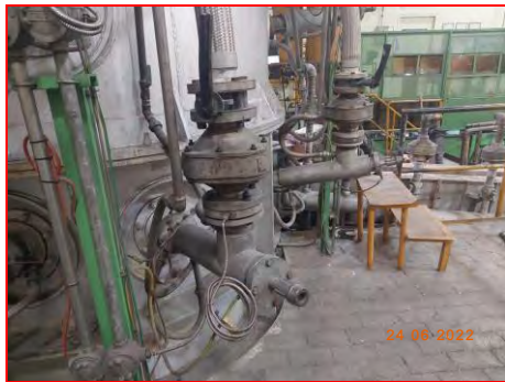
ภาพที่ 2.2-2 การติดตั้ง Low NO x Burner บริเวณเตาหลอม
