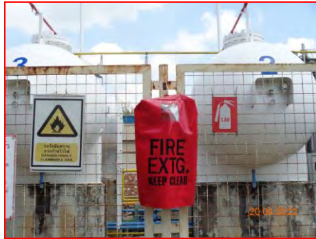
ภาพที่ 2.2-44 การติดตั้งถังดับเพลิงผงดมแห้ง บริเวณลานถังเก็บ LPG
