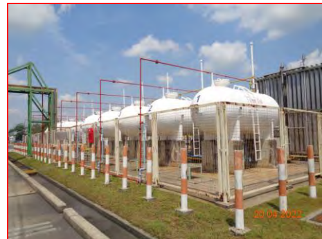
ภาพที่ 2.2-39 รั้วตาข่ายโปร่งกัน และเสาป้องกันการกระแทก บริเวณลานถังเก็บ LPG
