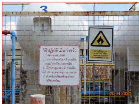
ภาพที่ 2.2-45 การติดตั้งเครื่องหมาย/ป้ายข้อห้าม ที่รั้วรายตัวของลานถังเก็บ LPG
